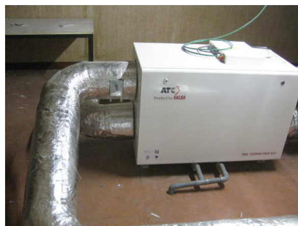
Centrale double-flux sanitaires
